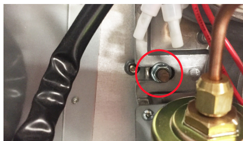
Lossa brännarens fästmuttrar på båda sidorna av brännaren (2 st.) och lyfta brännaren bort.
