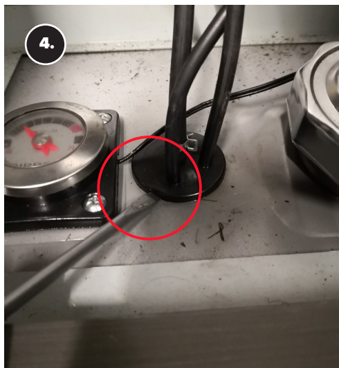
Irrota läpivientikumi ruuvimeisselin avustuksella ja nosta läpivientikumi ylös.
